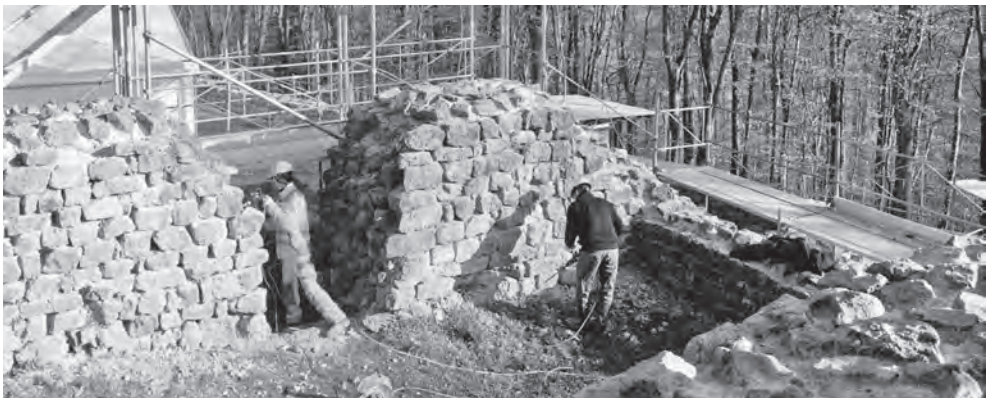
Sanierung der Ruine Altenberg
