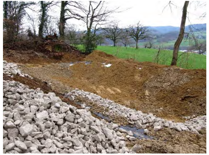
Die Kautschukfolie wurde ausgelegt und wird dann mit einem weissen Schutzvlies überdeckt, danach kommt das Weihersubstrat.
