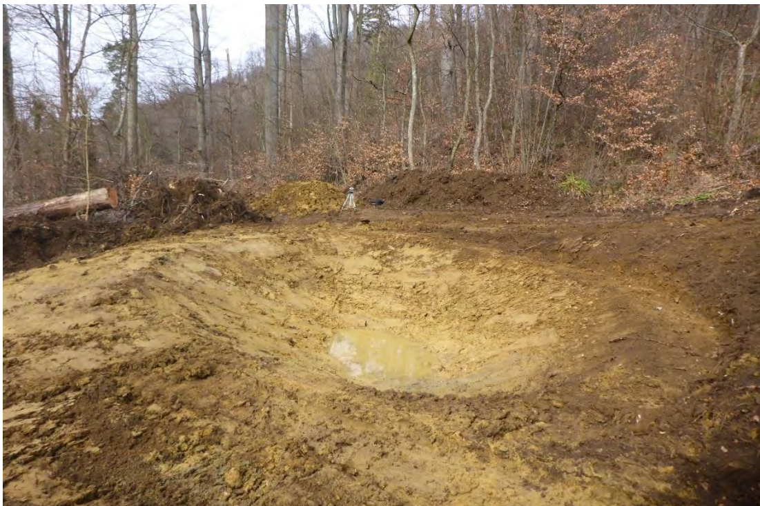
Nachdem der Aushub gemacht ist, drückt bereits Wasser aus dem Untergrund in den Weiher.
