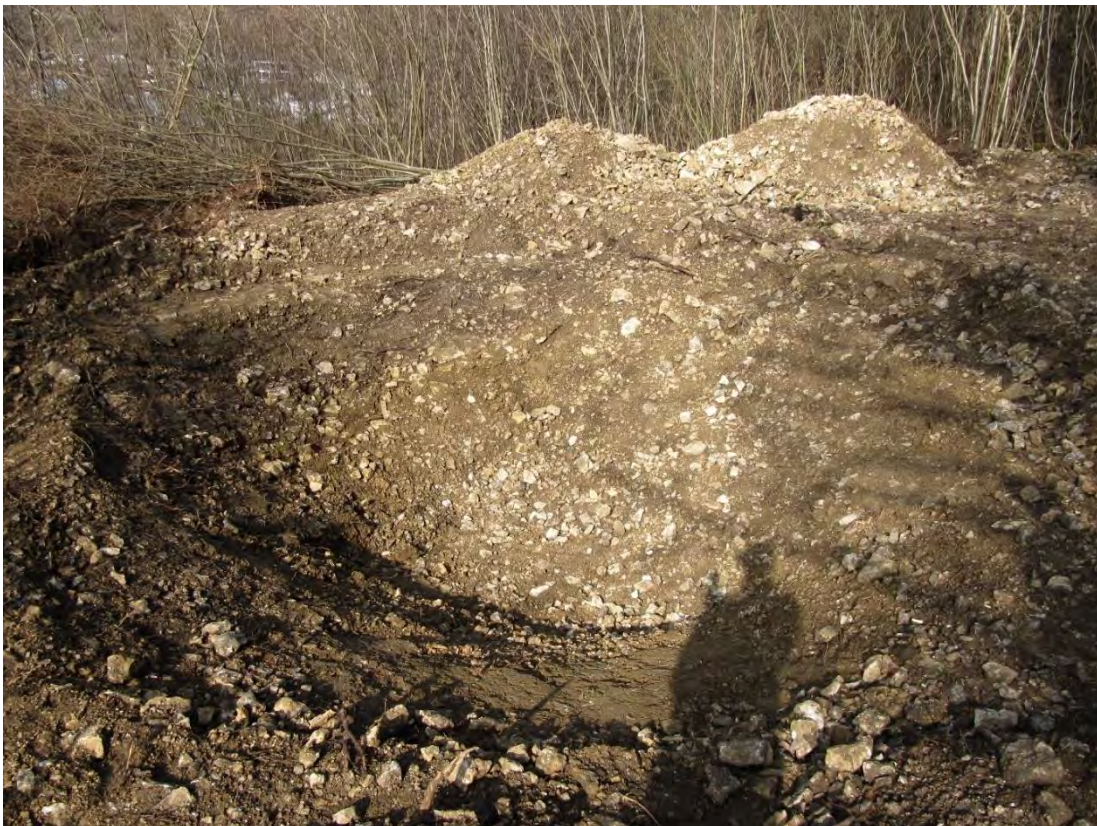
Der Aushub ist gemacht und bestand, wie auch bei Standort 2, aus Material, welches später wieder als Weihersubstrat verwendet werden konnte.
