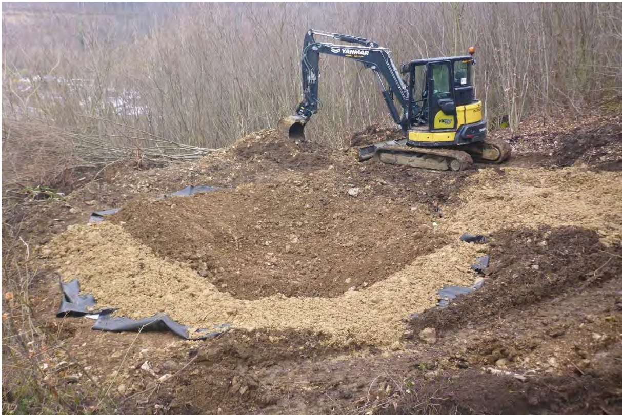
Das Aushubmaterial wird wieder eingebracht und mit zugeliefertem Gelbkies ergänzt.
