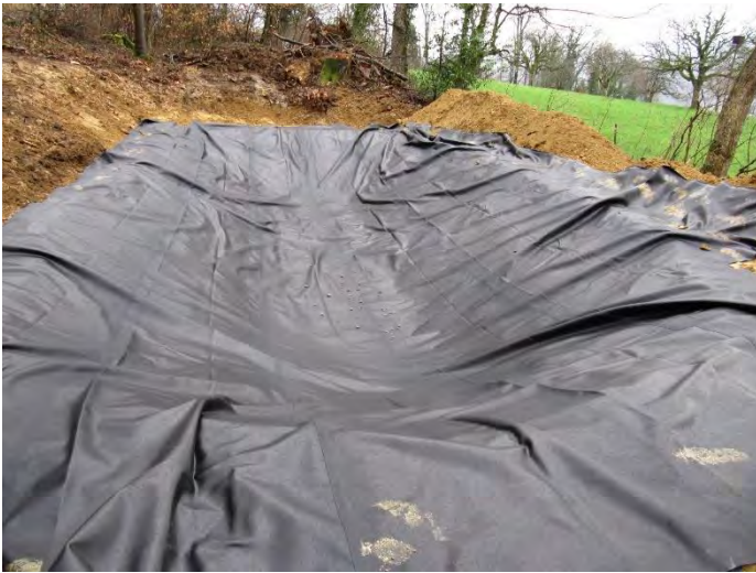
Die Kautschukfolie wurde ausgelegt und wird dann mit einem weissen Schutzvlies überdeckt, danach kommt das Weihersubstrat.
